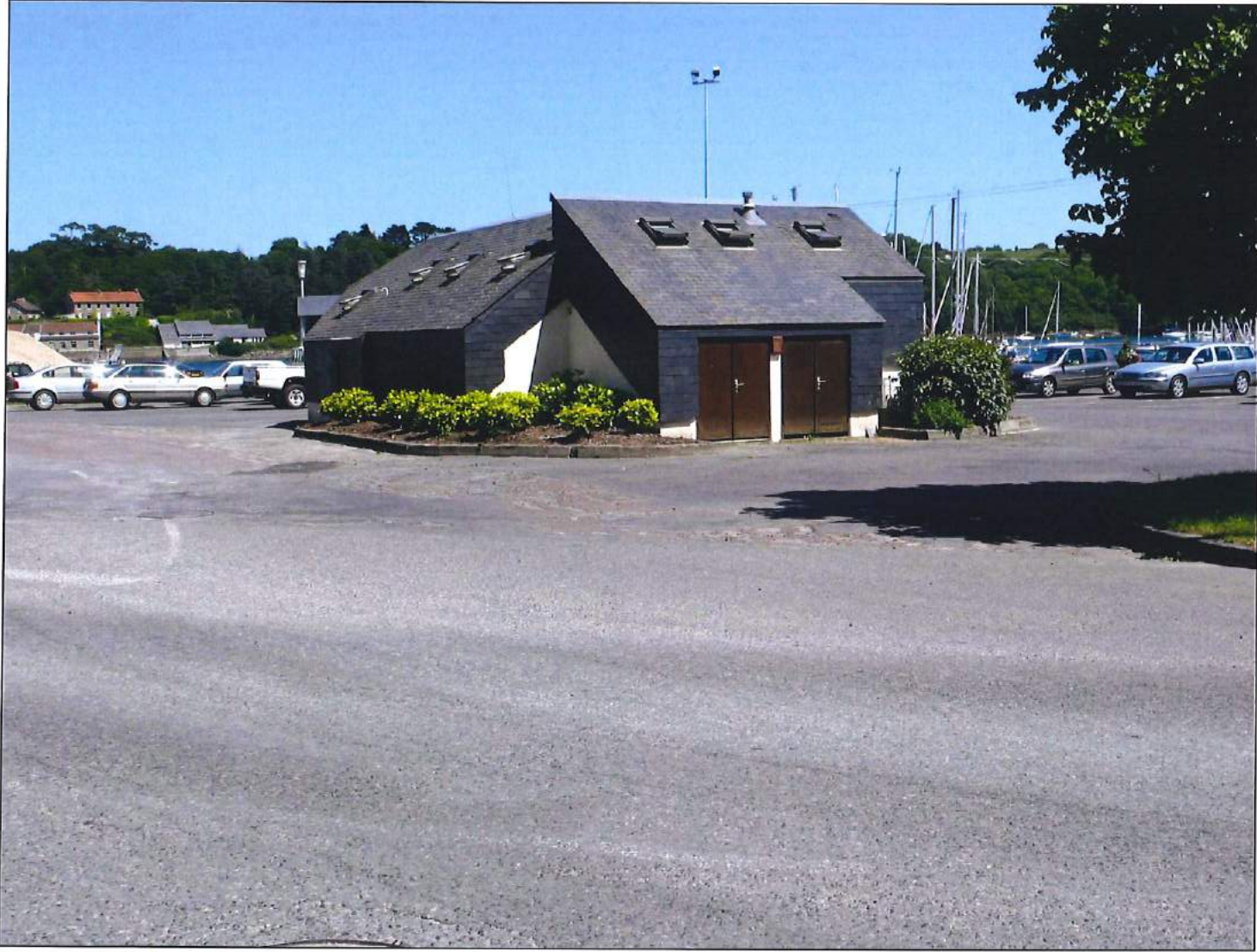
Sanitaires existants à démolir - 60m²
