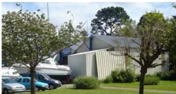
Bâtiment technique, pas de qualité architecturale
