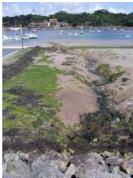
Figure 3-36 : Rejet de la station d'épuration et du ruisseau canalisé
