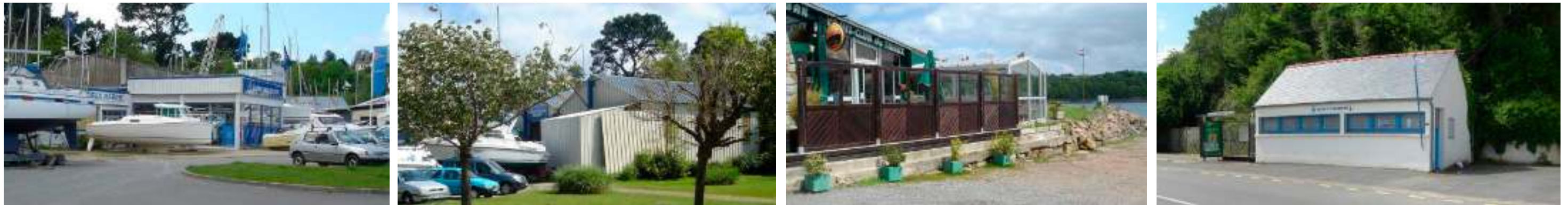
Bâtiment technique, implantation désordonnée, pas de qualité architecturale
