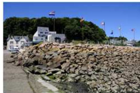
Omniprésence des enrochements
