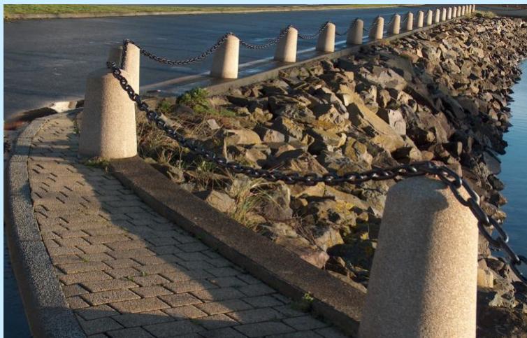
Protection de la voie le long du bassin à Flot
