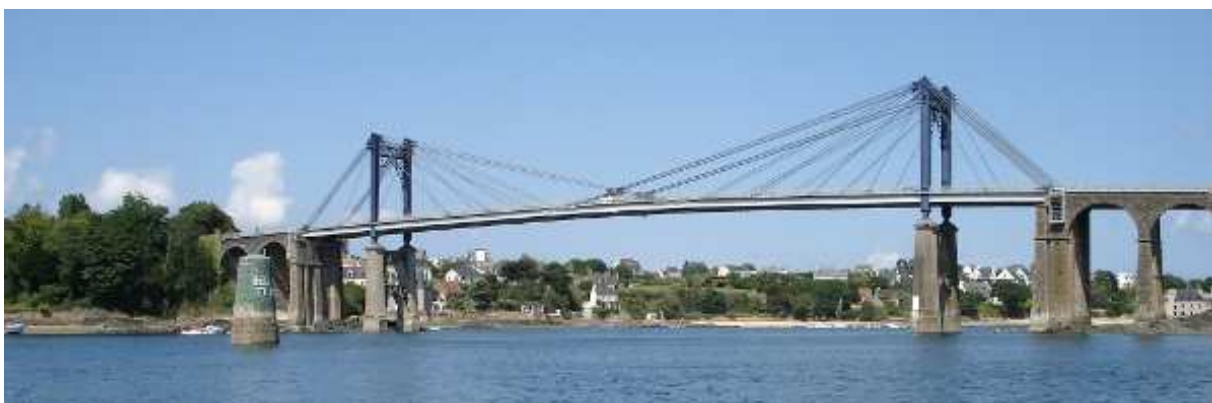
Pont suspendu (Source : http://www.mairie-lezardrieux.fr )
