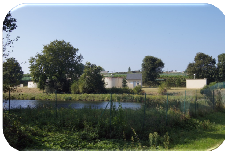
Station d'épuration de Lézardrieux
